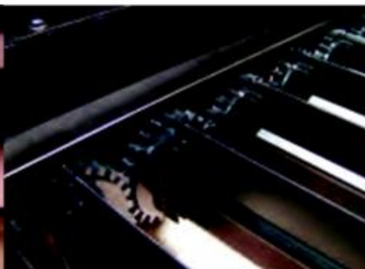
Compuerta SmartAire que acciona el VAV cuando está abierta de 0 % a 100 %
