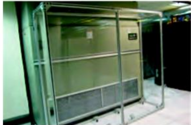
Protección del bastidor
